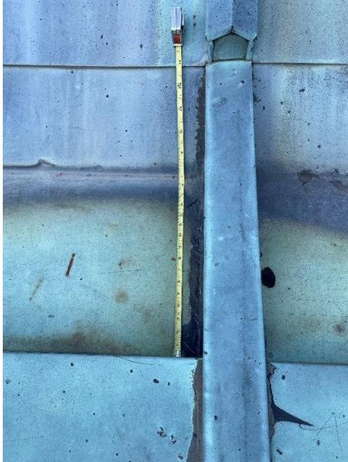
Gutter Pan Width
